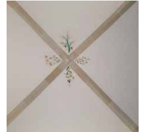
Ehemaliger Kochbereich der Klosterküche mit Gewölbe.
